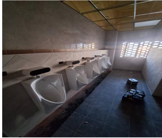
說明：便器施工
