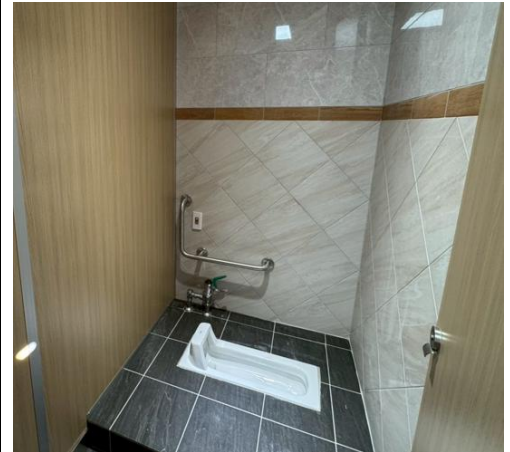
說明：新設便器美觀大方
