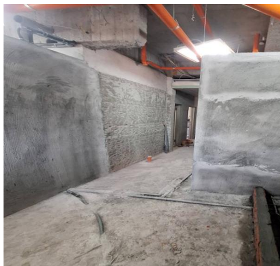
說明：牆面打底施工
