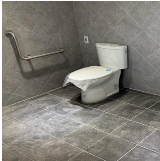
說明：便器施工
